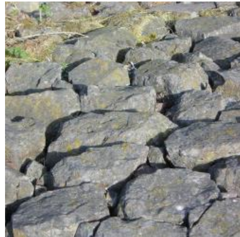
Figuur b8-1 | Opgeschoonde natuursteenbekleding Putterzeedijk
