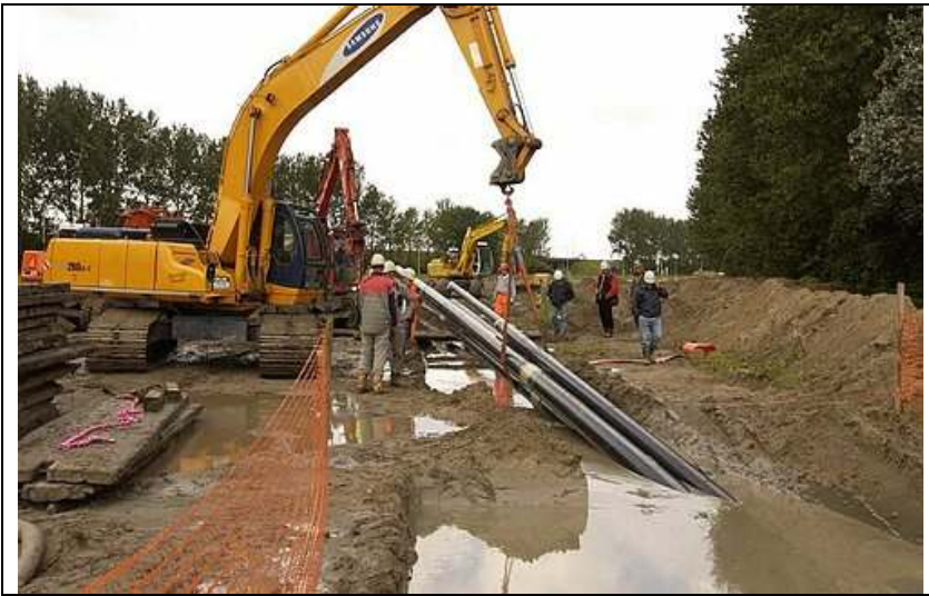
Figuur B3.7: Bundel PE-leidingen wat wordt ingetrokken
