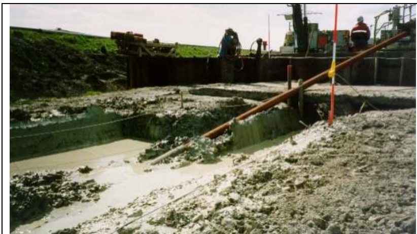
Figuur B3.2: Boorvloestof bij booringang
