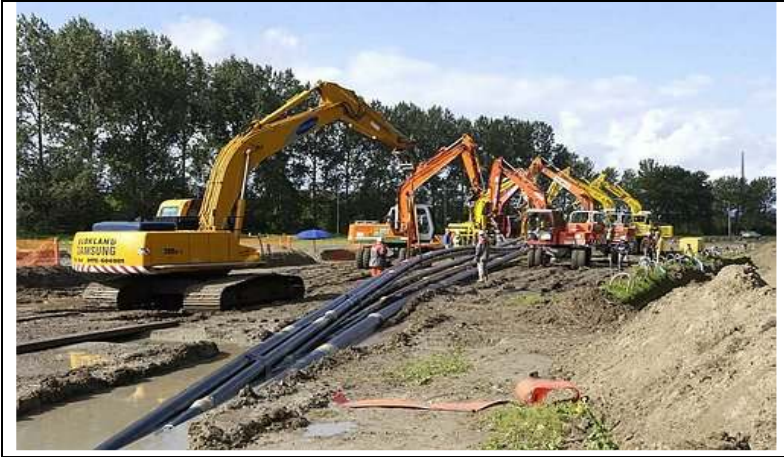
Figuur B3.6: Bundel PE-leidingen wat wordt ingetrokken
