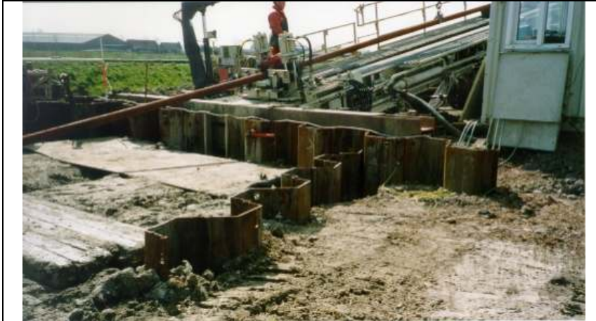
Figuur B3.1: Boorstelling bij door damwanden omringd booringang
