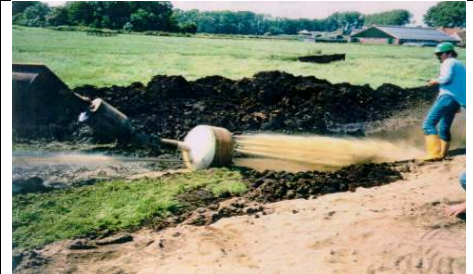
Figuur B3.4: intrekken boorkop
