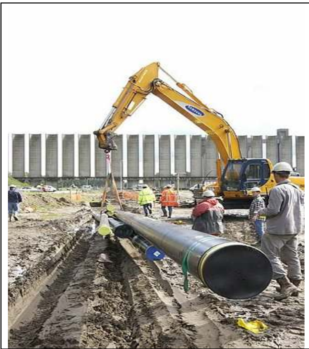
Figuur B3.5: Bundel PE-leidingen wat wordt ingetrokken onder een kanaal
