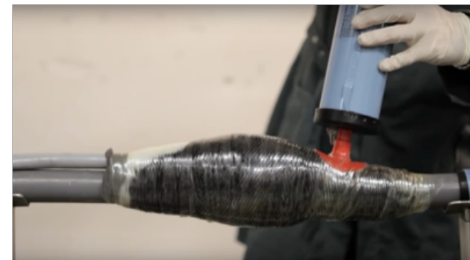
Fig. 22 :Filoform pers en wikkelmof
