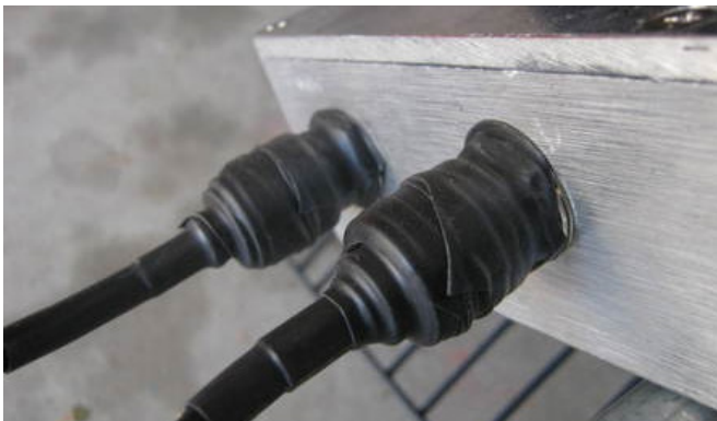
Fig. 7 :Afdichting met zelfvulkaniserende tape
