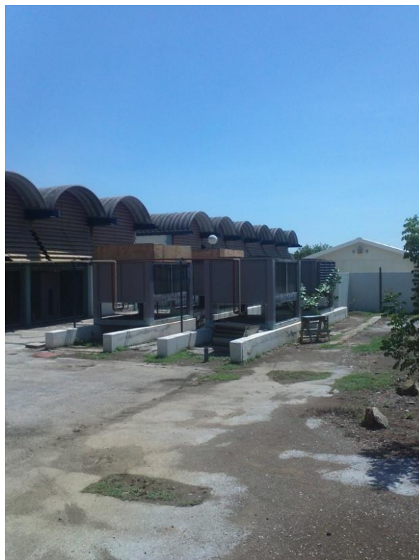
Figuur 14: Condensoren omringd door gebouwen
