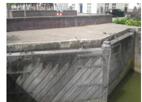
Figuur 16 - Sluisdeuren voor de De La Sablonièrekade (Oorgatsluis)
