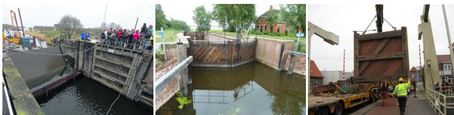
Figuur 27 - Sluisdeuren, v.l.n.r. - Klepdeur, puntdeur, hefdeur
