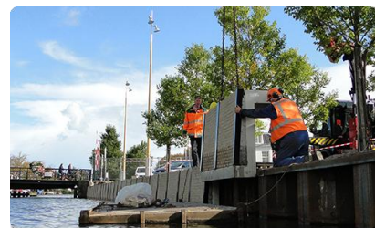
Figuur 24 - Stalen damwanden met kadeshort
