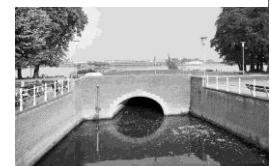
Figuur 17 - Doorgang Sablonièrekade
