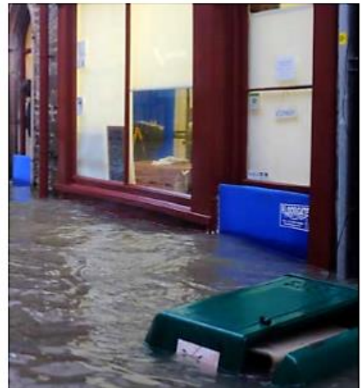
Figuur 5.136 Deurschot met inklemsysteem (Vlaamse Milieumaatschappij, 2015)
