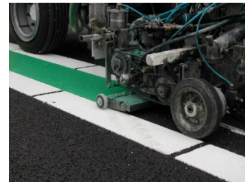
Figuur 7: aanbrengen koudplast [9]
