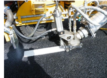
Figuur 3; Thermoplast gieten [5]
