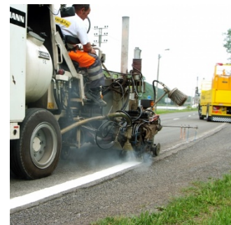
Figuur 2; Thermoplast spuiten [4]
