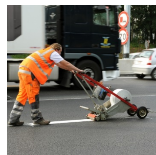
Figuur 5: aanbrengen overlay [7]
