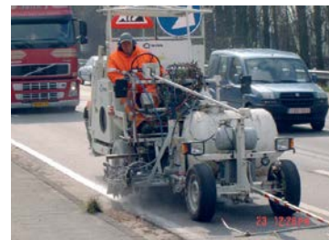
Figuur 1: Aanbrengen wegenverv [3]
