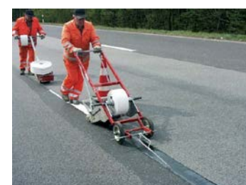
Figuur 6: aanbrengen inlay [8]
