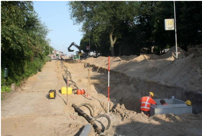
Figuur 3. Rioolwerkzaamheden in de gemeente Zutphen
