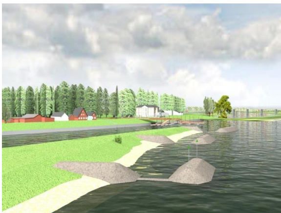
Figuur 21: Zijaanzicht eilandkribben bij laag water (Witteveen+Bos, 2011)
