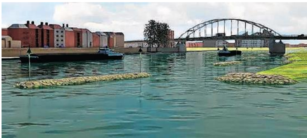
Figuur 7: Schematische weergave van de eilandkribben bij Deventer (Waterschap Groot Salland, 2015)
