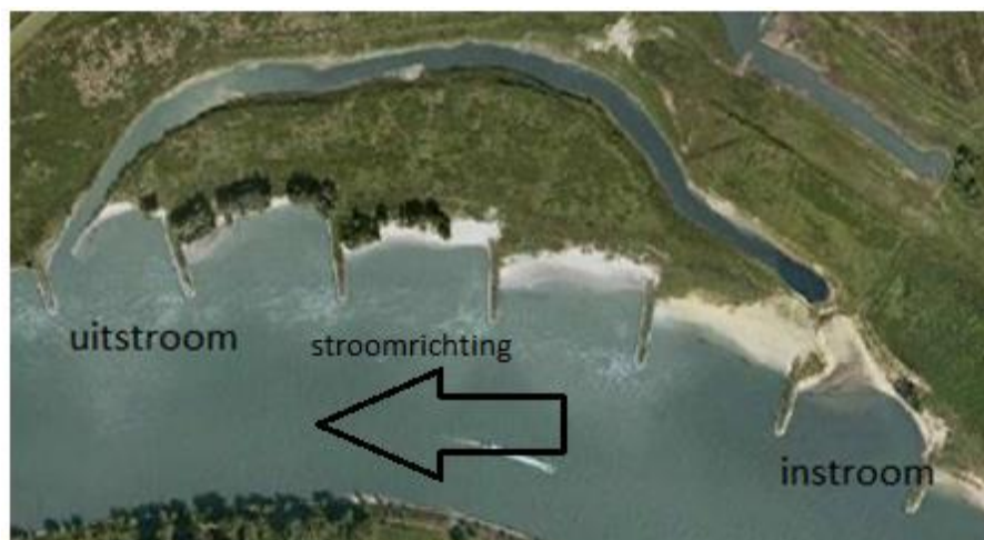
Figuur 9 luchtfoto Klompenwaard
