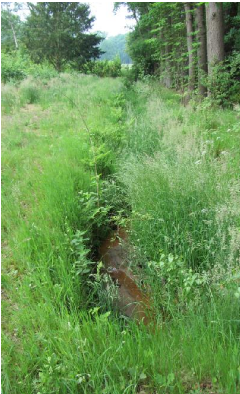
Figuur 27 Indicatie van de huidige toestand van de watergang in het zuiden van 'het Bouwhuis'
