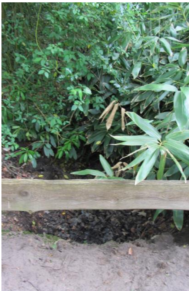
Figuur 30 Indicatie van de huidige toestand van de verbinding tussen de watergang in het noorden van 'het Bouwhuis' en de vijver in oosten van het landgoed
