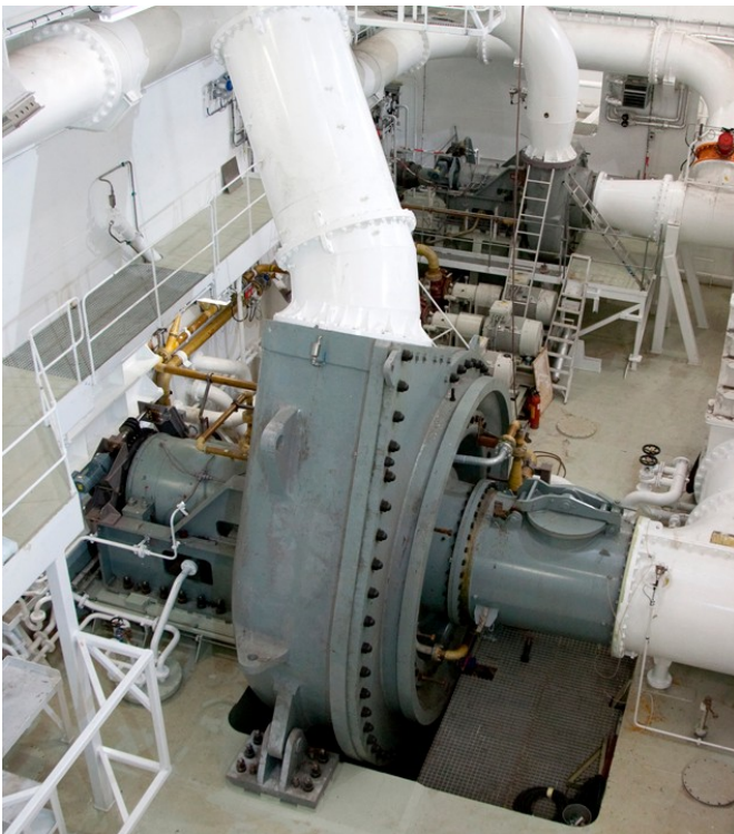
Figuur 1.4: Baggerpomp
