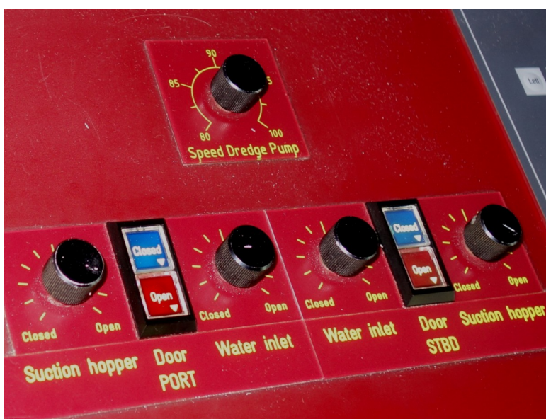
Figuur 2.3: Bediening afsluiters en baggerpomp
