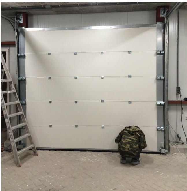
[Fig 13] Montage overheaddeur
