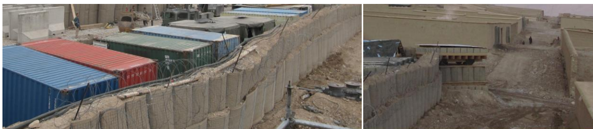
Figuur 18: (L) Perimeter (R) Wachtpost
