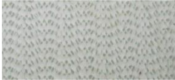
Figuur 10.6 De antislip laag.
