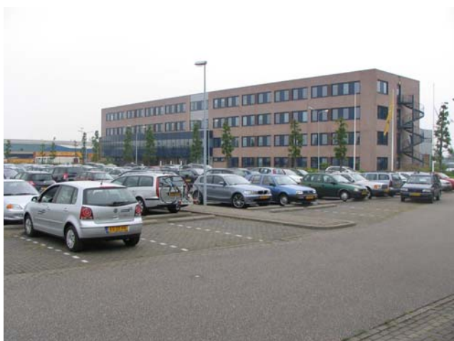
Figuur 12.8 Parkeerterrein Dp Botlek
