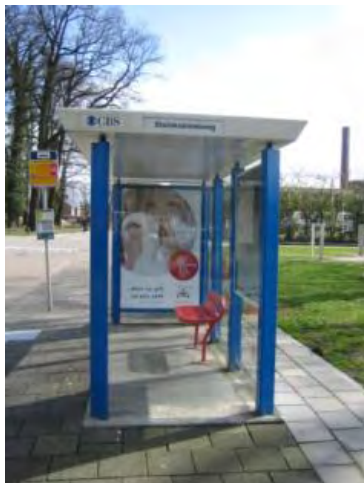
FIGUUR 192 OPENBAAR VERVOER, PUBLIEK, LICHTE CONSTRUCTIE
