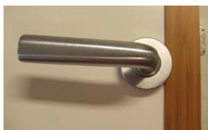
Figuur 112; Aansluiting rozet en lat
