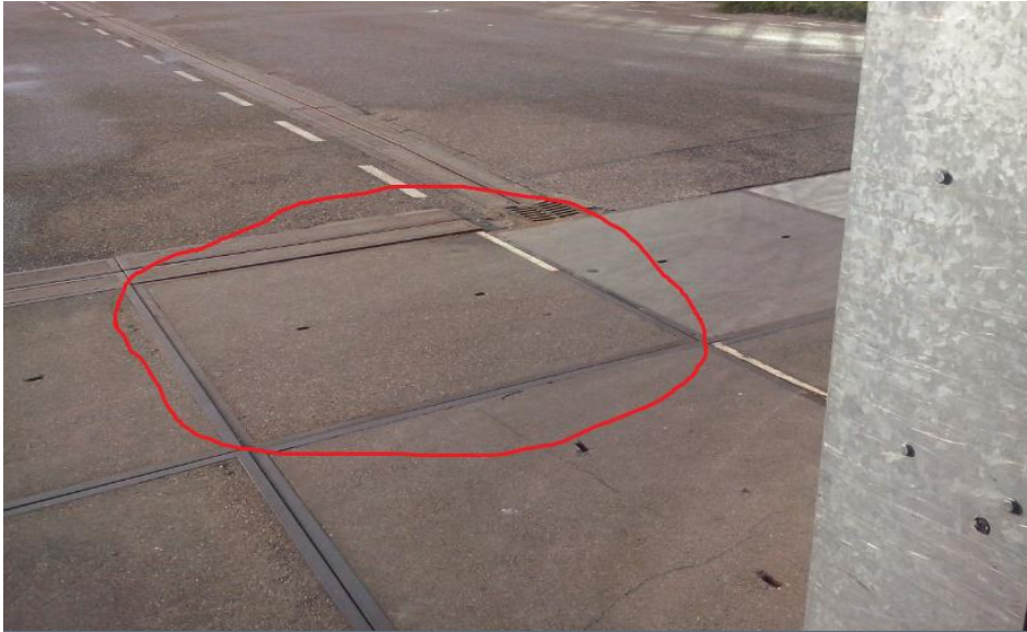
Figuur 7-1 Wegdek productieterrein, stelconplaat rood omcirkeld
