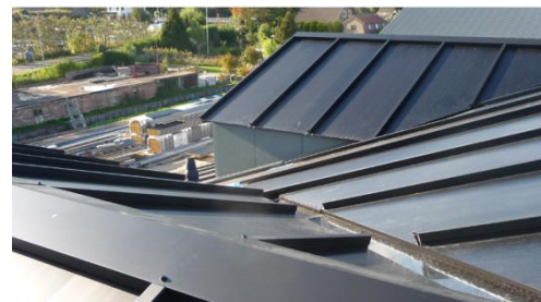
Afbeelding 3.1-e Dak van Sandwichpanelen (Triple Solar, 2011)
