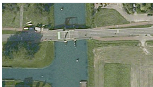
Figuur 16 Bovenaanzicht Marknesserbrug
