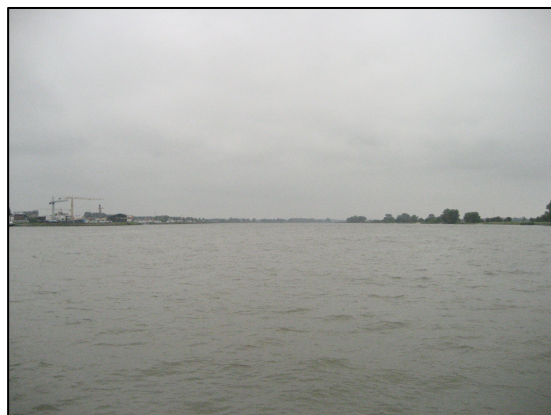
Figuur 2-3: De Nieuwe Merwede vanaf het splitsingspunt Boven Merwede – Beneden Merwede / Nieuwe Merwede
