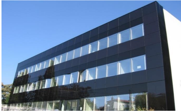
Figuur 9 BIPV gevel system (PolySolar, 2017)
