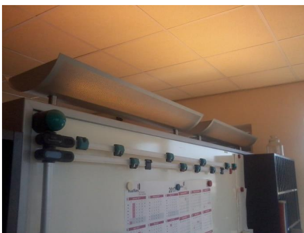
Figuur B2.4: opstaande armatuur met 4 tl-lampen
