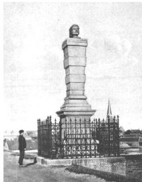
Figuur B-2 De Stenen Man op het binnentalud (van der Pol, 2017)
