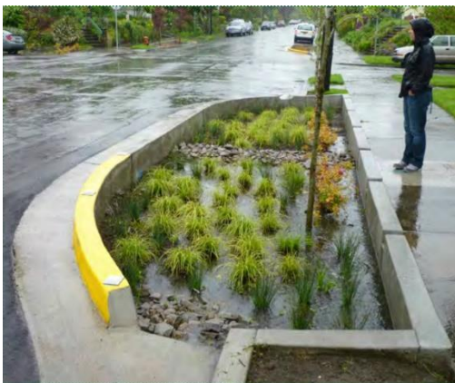
Figuur 1 – Voorbeeld stedelijke infiltratiestrook (Environmental services - City of Portland, 2012)
