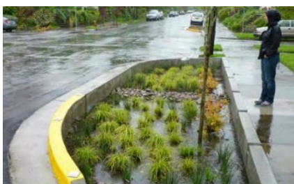
Figuur 48 - Voorbeeld stedelijke infiltratiestrook Portland (Environmental services - City of Portland, 2012)
