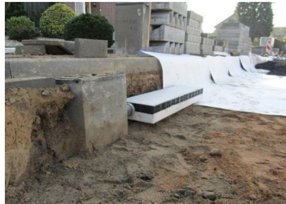
Figuur 2 – Kolk naar waterbergend pakket met bezinkunit (Aquaflow, 2017a)
