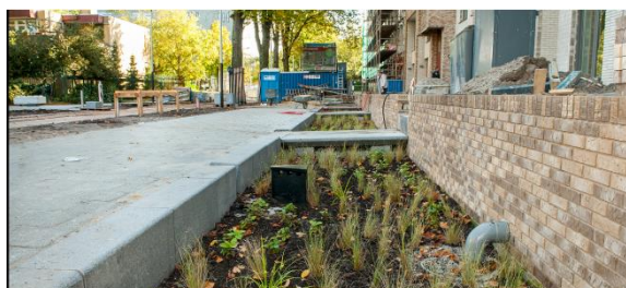
Figuur 49 - Voorbeeld stedelijke infiltratiestrook Amsterdam (Amsterdam Rainproof, 2016)
