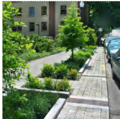
Figuur 28 – Voorbeeld stedelijke infiltratiestrook (Environmental services - City of Portland, 2012)
