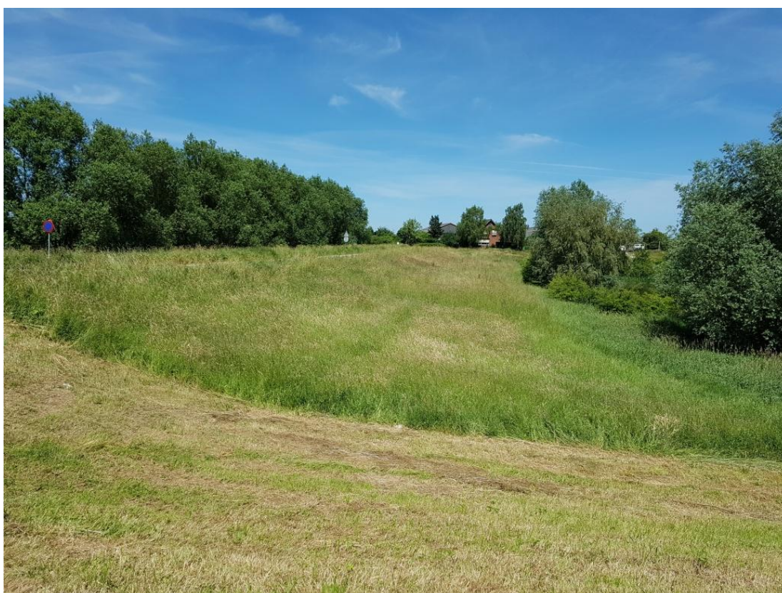
FIGUUR 21 FOTO VANAF DE ZIJKANT VAN DE DAM
