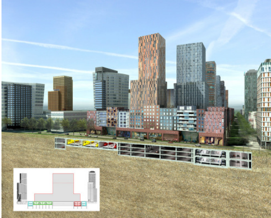
Figuur 2 – Overkluizing van de A10 bij de Zuidas van Amsterdam. Niet alleen de A10 bevindt zich onder het maaiveld, maar ook parkeervoorzieningen, een leidingkoker en een HSL-station.
