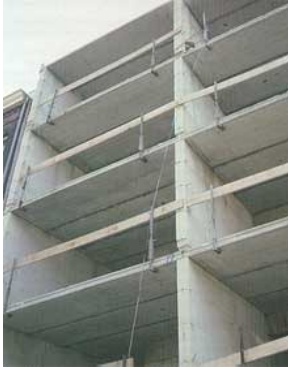
Figuur 7- Een voorbeeld van gietbouw. Het repeterende karakter van deze bouwwijze is duidelijk zichtbaar ( www.perfectbouw.nl/Kennisbank/betonvloeren.html )
