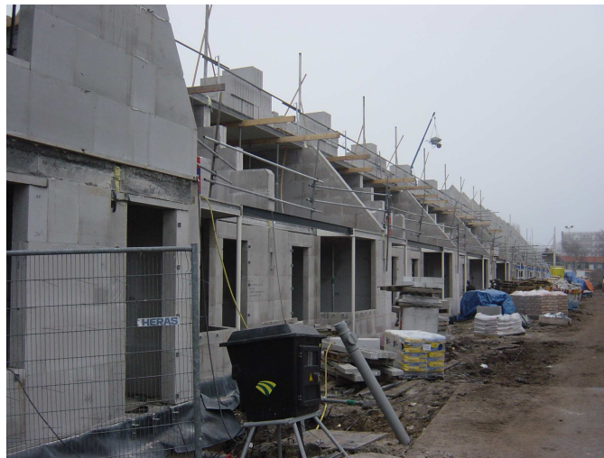
Figuur 6: Ruwbouw met kalkzandsteenblokken (project D. Doniastraat, Zaandam)
