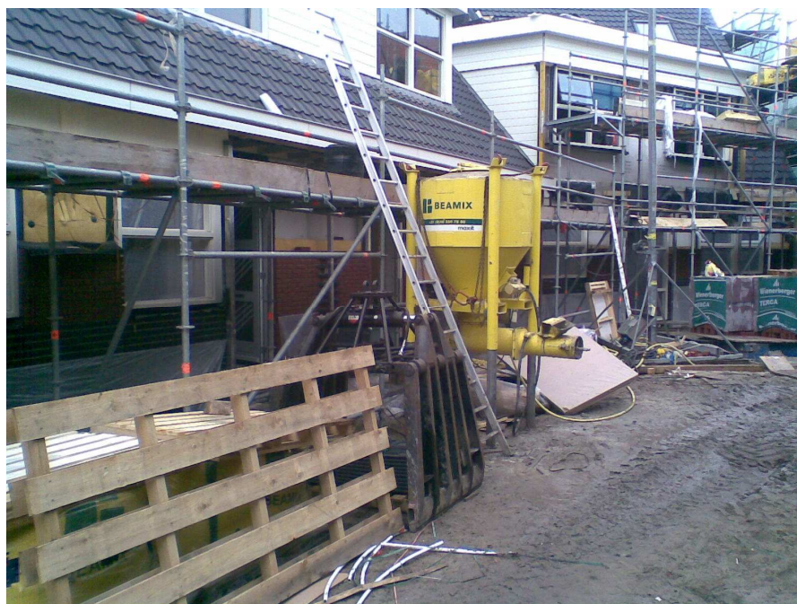
Figuur 10: Voorbeeld van knelpunt krappe bouwplaats, materiaal moet op de bouwweg, voor de steiger worden opgeslagen (project D. Doniastraat, Zaandam)
