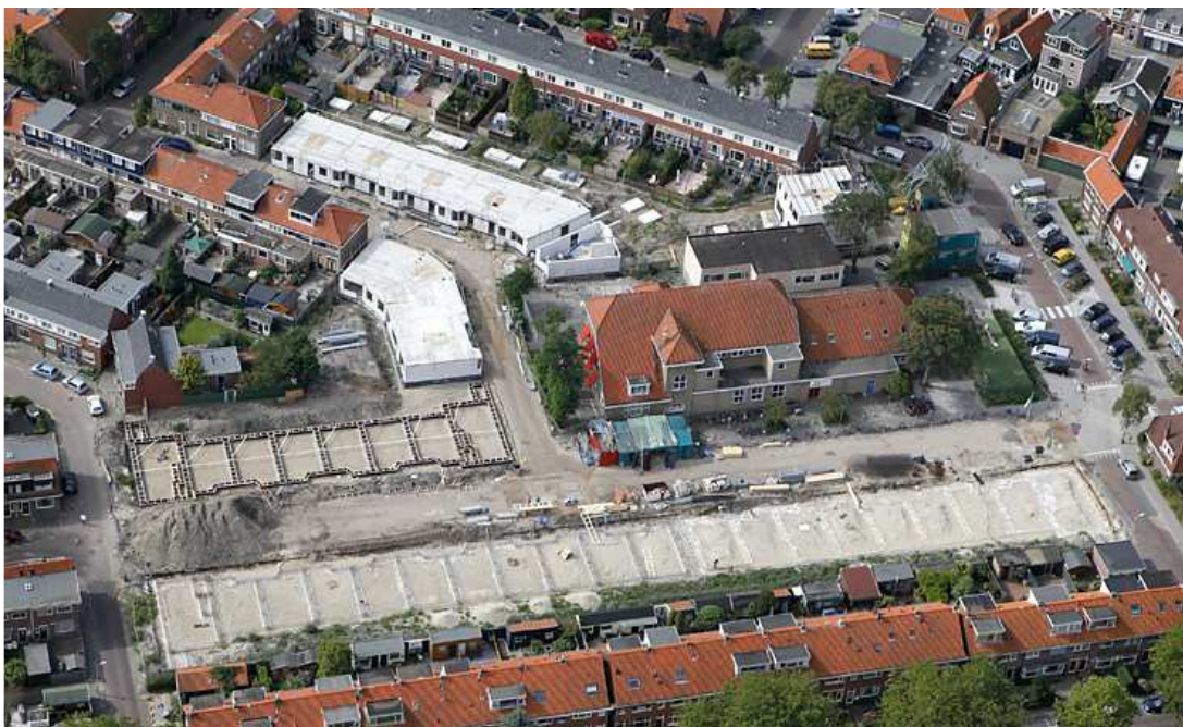
Figuur 1: Luchtfoto van bouwproject D. Doniastraat, Zaandam. Duidelijk te zien zijn de gefaseerde bouw en de basisschool ingesloten door bouwactiviteit (foto: Calduran)
