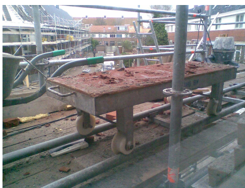
Figuur 12: Voorbeeld van productinnovatie: transport van bakstenen via een railsysteem op de steiger (project D. Doniastraat, Zaandam)
