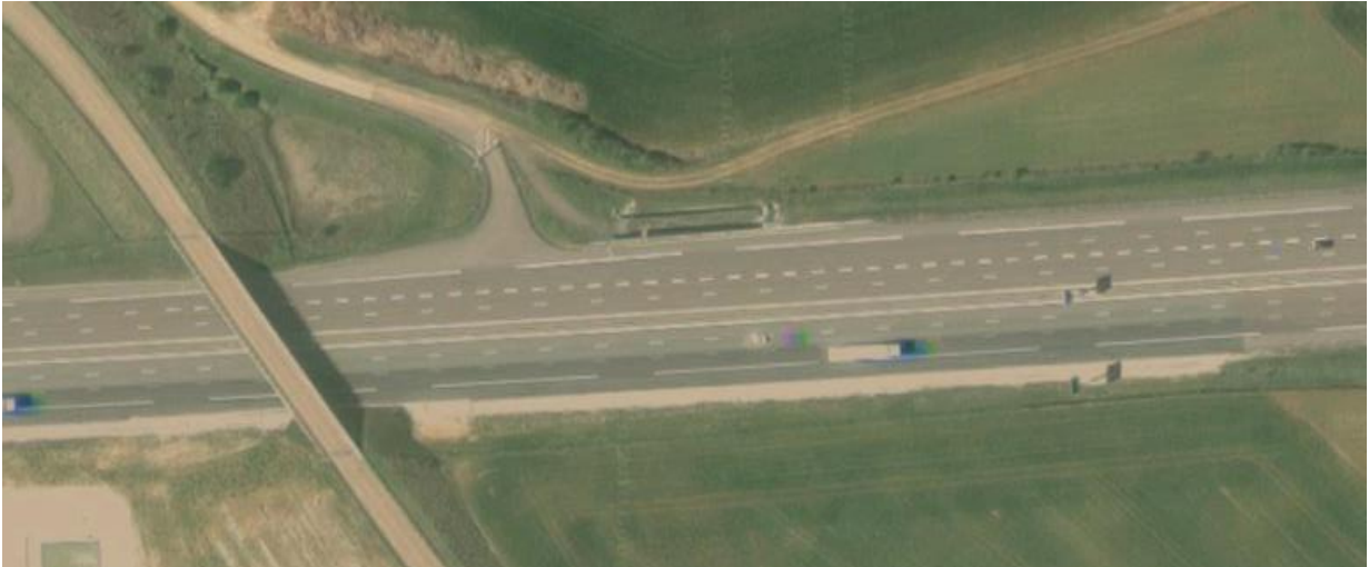
Figuur 15-38 Rechter afstropping op de Franse Autoroute bij het knooppunt A31/A5
