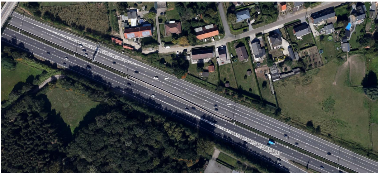
Figuur 15-33 Rechter afstropping (met verdrijfvlak) op de Belgische Autosnelweg bij knooppunt Ranst (A21/A13)
