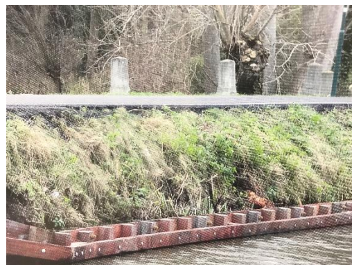
en Constructie proefbeschoeiing 1 en 3 (den Boer & Treur, 2018)
