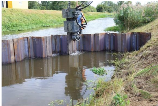
Figuur 16: Foto's van damwanden, staal en hardhout (Richard, 2016; Denzo, 2016)
