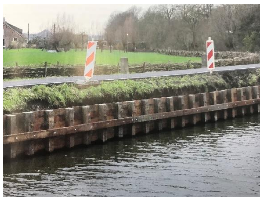
Figuur 14: Constructie proefbeschoeiing 2
