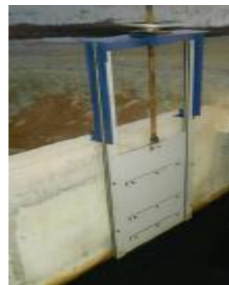
Figuur 7 Voorbeeld spindel
