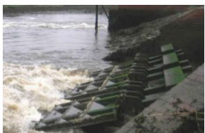
Figuur 34 Voorbeelden kleppen met tegengewichten
