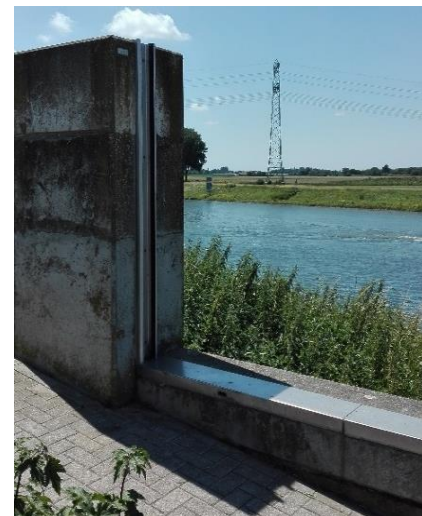
Figuur 2 Tijdelijke kering niet in gebruik bij de Maas
