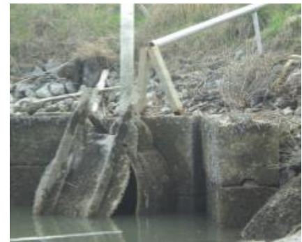
Figuur 28 Klepontwerp III: toevoeging constante veer
