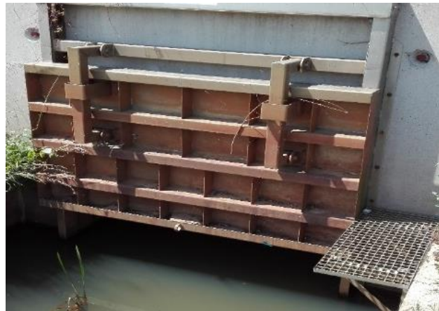
Figuur 16 Wanneer het OKP is bereikt zal de beheerder de klep losmaken en de zwaartekracht zal hem vast schuiven in zijn positie voor de buis
