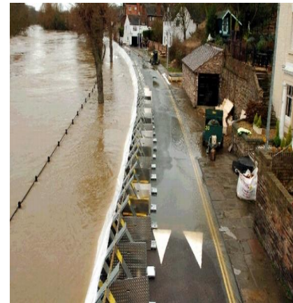
Figuur 1 Tijdelijke kering in gebruik
