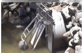
Figuur 35 Voorbeeld klep met drijver
