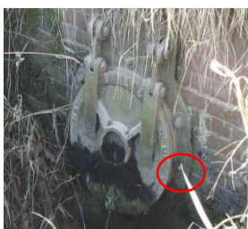
Figuur 32 Voorbeeld blokkeren kleppen
