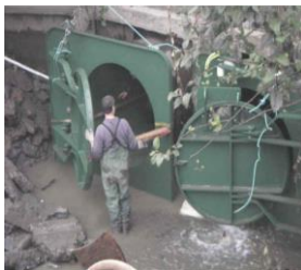
Figuur 31 Voorbeeld waterkering-deur
