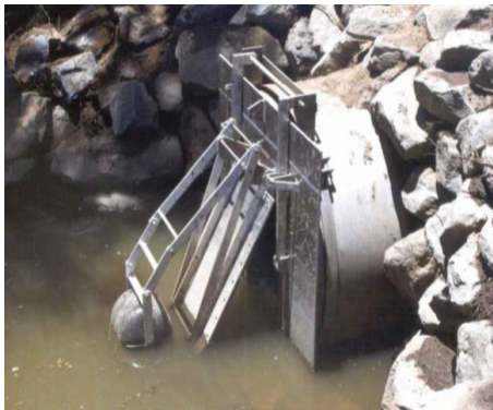
Figuur 23 Drijver-terugslagklep
