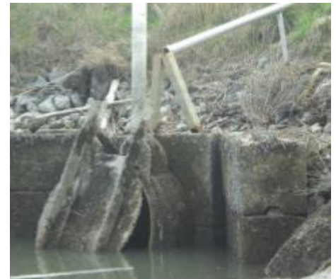
Figuur 22 Constance veer terugslagklep
