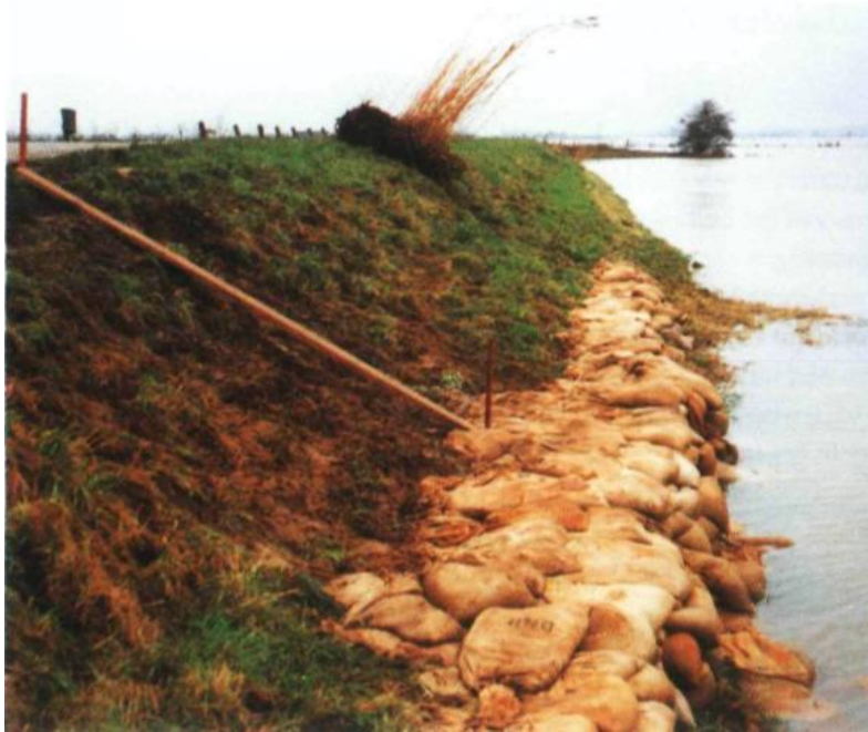
Figuur 7: Ongeveer twee dagen nadat de topafvoer gepasseerd was, is het buitentalud van de Rijnbandijk bij Ingen verzakt. Vervolgens is deze versterkt met zandzakken.
