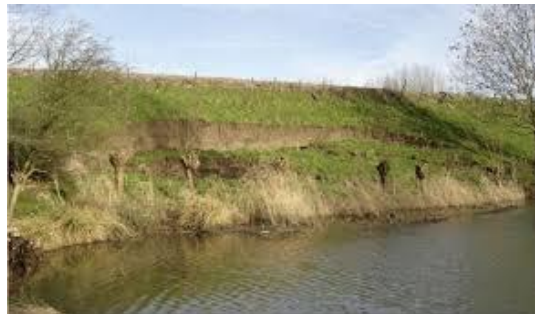
Figuur 2: Afschuiving door instabiliteit van het talud (Helpdesk Water, 2019)
