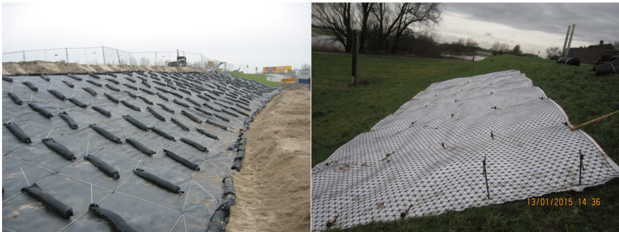
Figuur 9: Traditionele bekramming met zandzakken (links) versus innovatieve bekramming met kunststof wapeningsnet (rechts)
