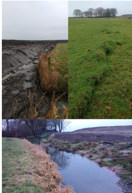
Figuur 6: Lichte afschuiving tijdens werkzaamheden Reevediep. Linksboven: dichtgedrukte sloot; rechtsboven: golfvorming land achter sloot en onder: lichte afschuiving
