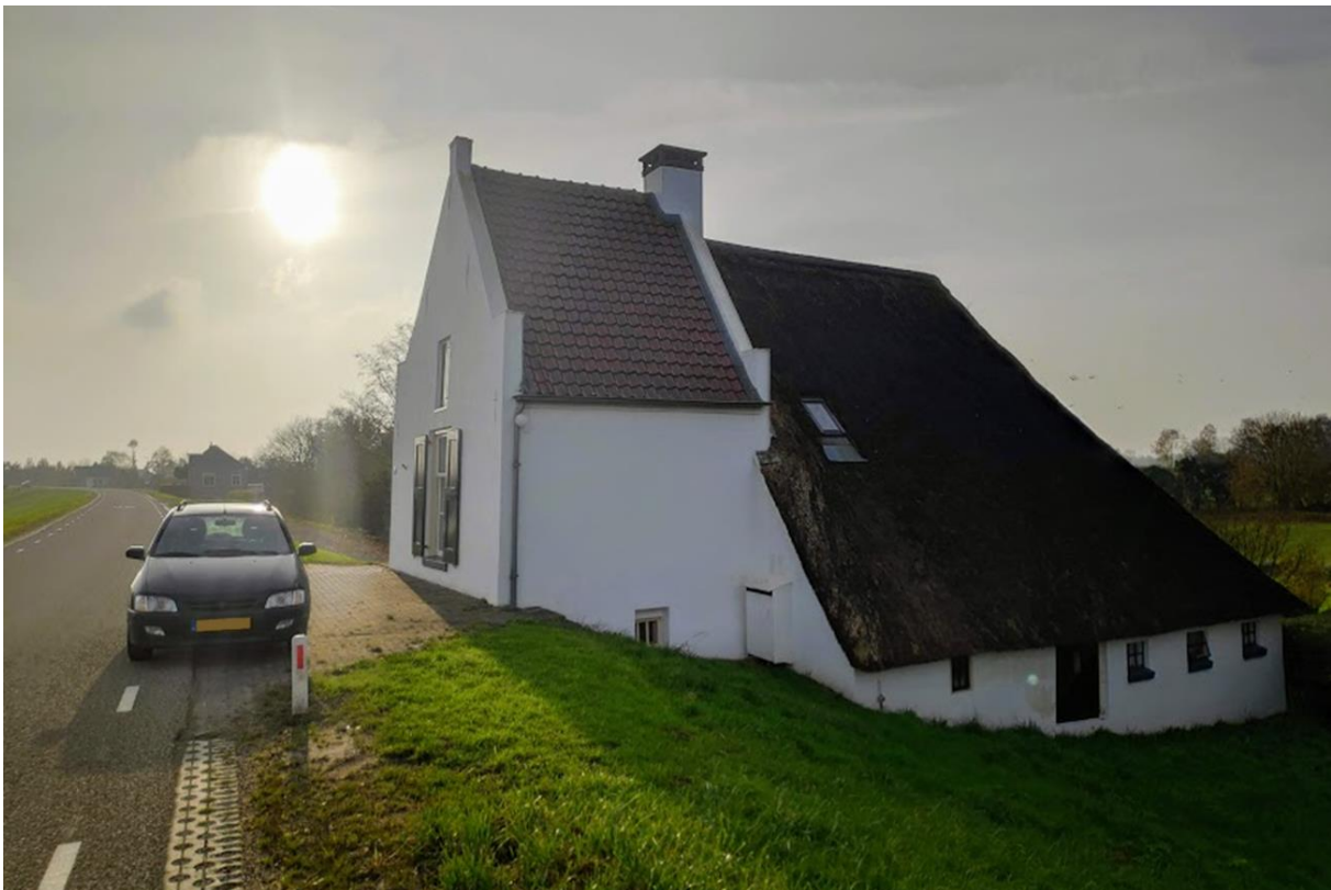
Figuur 4.1 – Foto van de gekozen maatgevende dijkwoninglocatie IJsseldijk 45 te Welsum vanaf de noordzijde geschoten.
