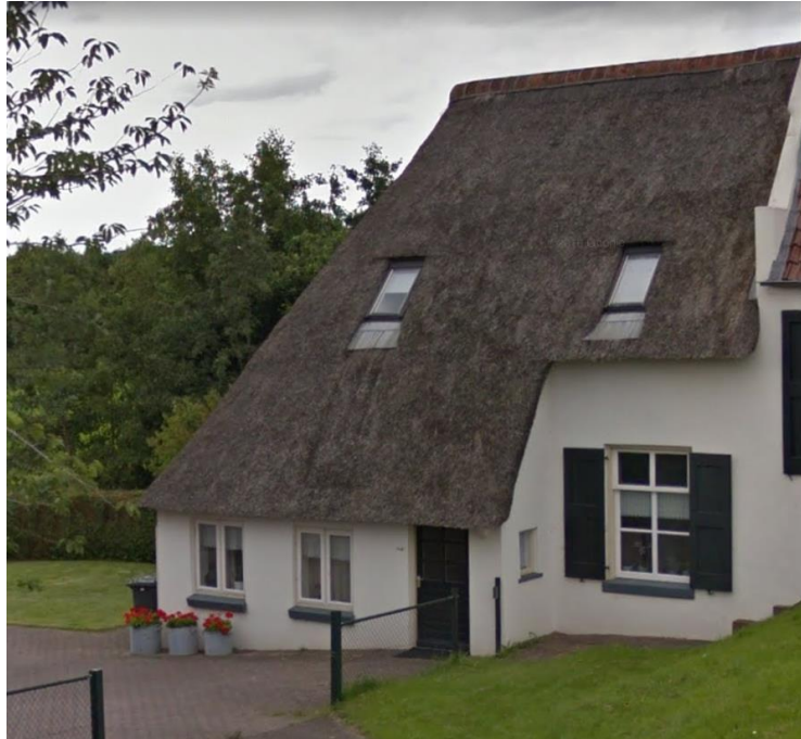
Figuur E.2 – Zijgevel van IJsseldijk 45, met aflopend grondlichaam.
