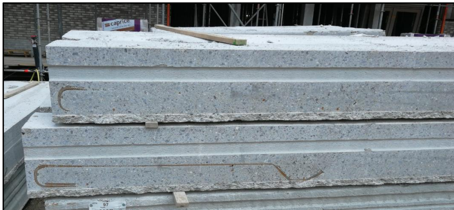
Figuur 19: VBI Appartementenvloer pasplaat met DSS wapeningskorf [projectbezoek Van Wijnen, Soesterberg].
