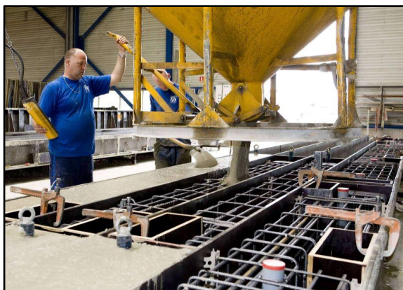
Figuur 7: Productie funderingsbalken [fabriek IJB te Lemmer].
