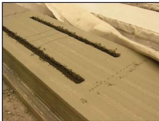
Figuur 15: Leidingsleuven worden uit de vloer 'gezogen' [fabriek VBI te Huissen].
