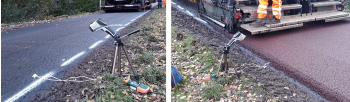
Figuur 16: Opstelling meetapparatuur vóór (links) en na (rechts) aanbrengen asfalt
