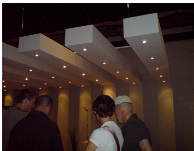
Plafonddelen met inbouwspots
