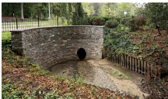
Figuur 17: Zaksloot bij Station Driebergen-Zeist (Kennisportaal Klimaatadaptatie, 2021)
