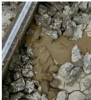
Figuur 5: Problematische waterafvoer (Dindar et al, 2017)
