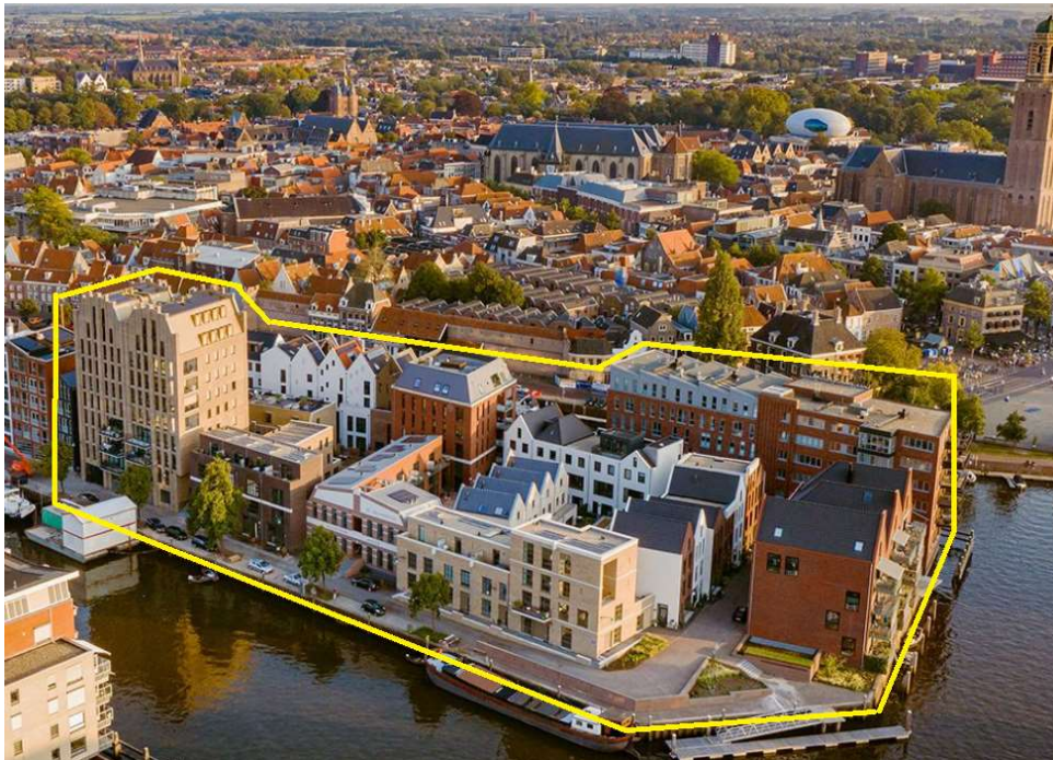
Figure 9: Overview finished project Kraanbolwerk (VanWonen, n.d.)
