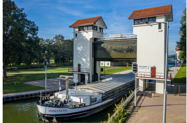
Figure 10.3: Lock Delden (Rijkswaterstaat, 2023a)
