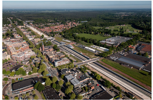
Figure 8.3: Salland Twente Tunnel Rijkswaterstaat, 2023e
