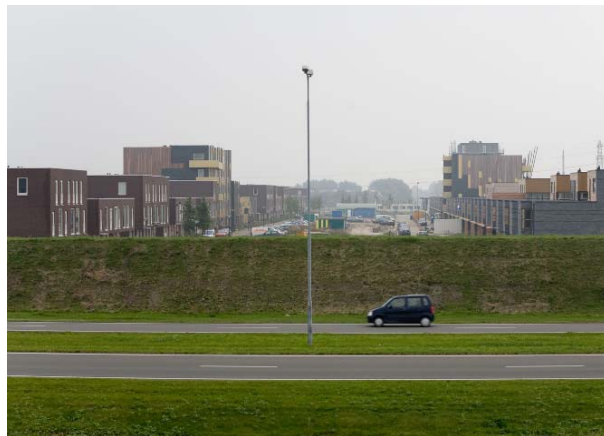
Figuur 10 Aarden geluidswal rondom woonwijk in Hoofddorp (R. Sluiter)
