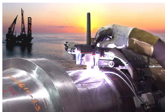
1.2.4.a Toepassing van een orbitale lasmachine in het lassen van buizen op een boorplatform
