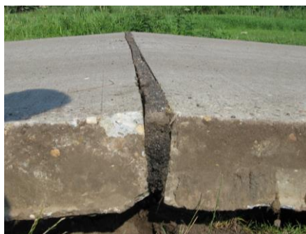
Figuur 7: Spatting bij een betonweg
