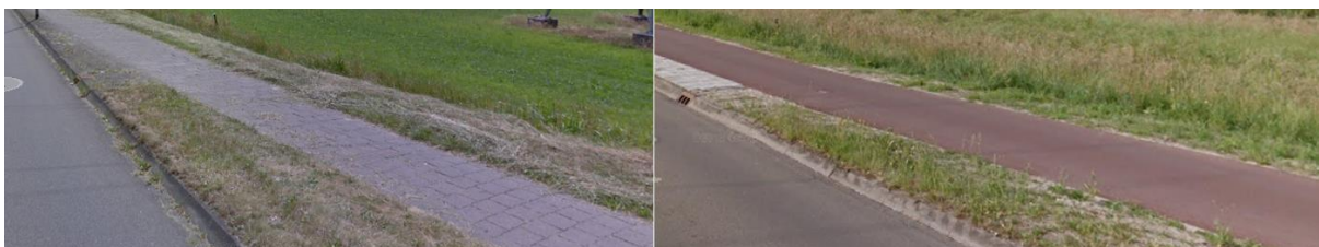
Figuur 5: Links het oude tegelfietspad, rechts het nieuwe asfaltfietspad
