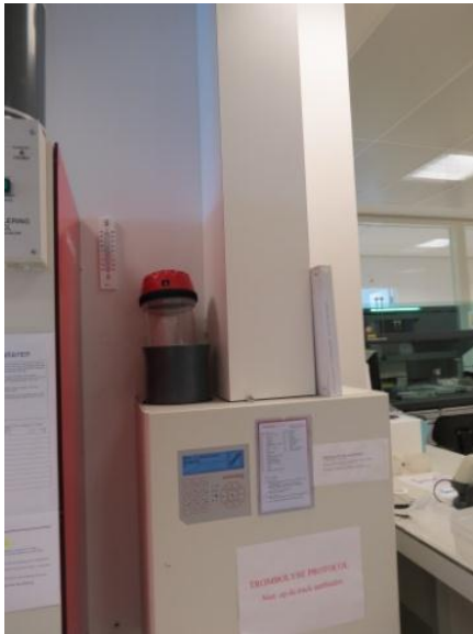
Figuur 10 - Buizenpoststation met verzendbuis
