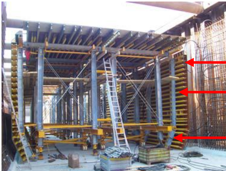
Figuur 7 Opbouw modulaire bekisting (Bron: Heijmans document)
