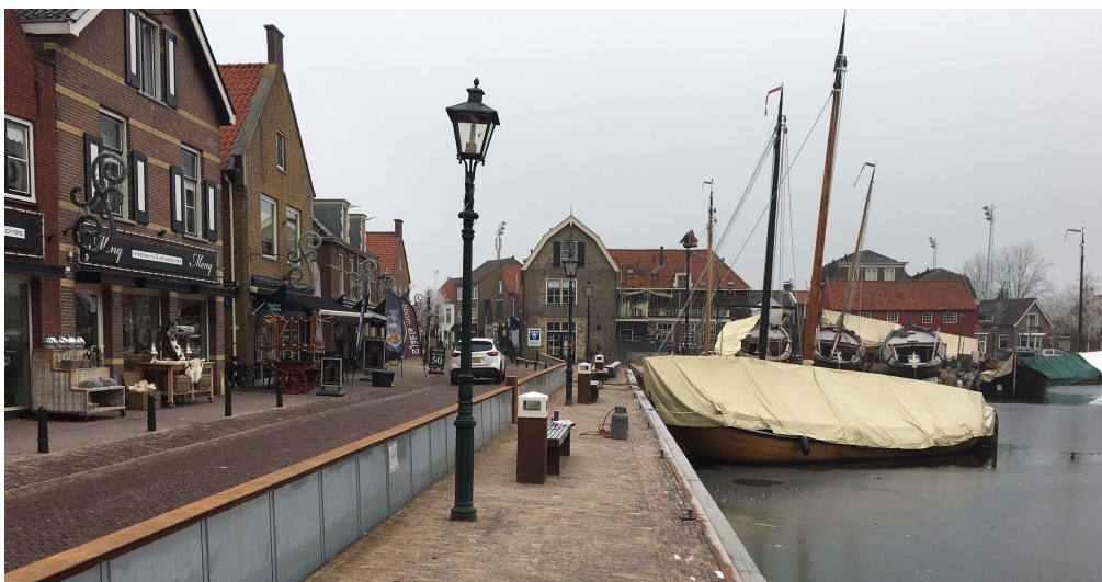
Figuur 3, Automatische drijvende waterkering in Spakenburg (Aggeres, 2017).
